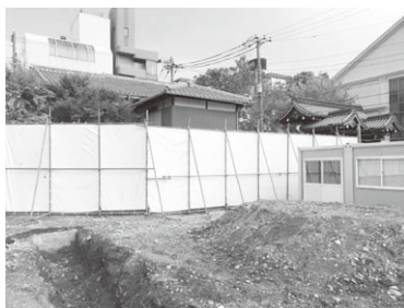
現場仮囲いも▶
