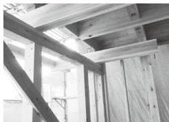
通し柱も間柱も 4寸角の頑丈な構造
