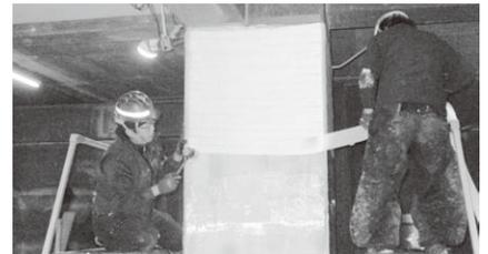
包帯補強:補強材巻き施工(1巻き目)
