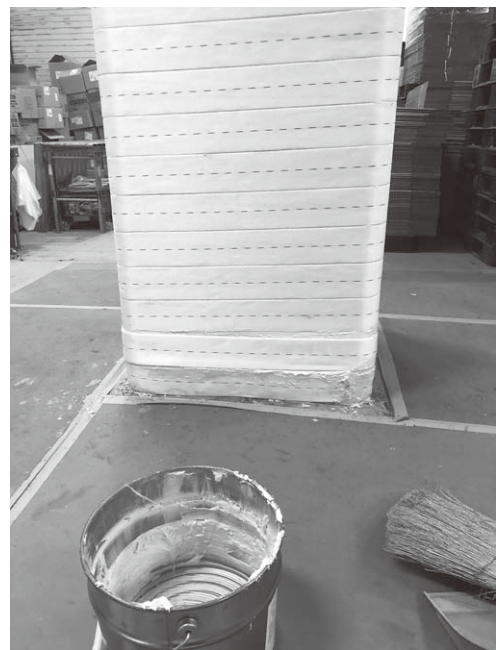
SRF施工現場
