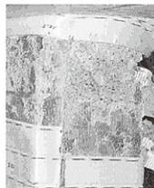
繰り返しの地震の揺れに強い「SRF工法」強靱で柔軟なポリエステル繊維製のベルトを巻きつけ・貼りつける耐震補強工法です。震度7クラスの揺れを数回加えても、倒壊しないだけでなく揺れも抑えることが確認されています。
