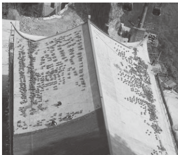
現地の瓦屋根施工中
